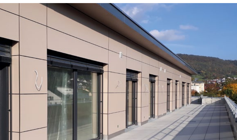
Gebäude Wagner Straße 23-25, Donzdorf
