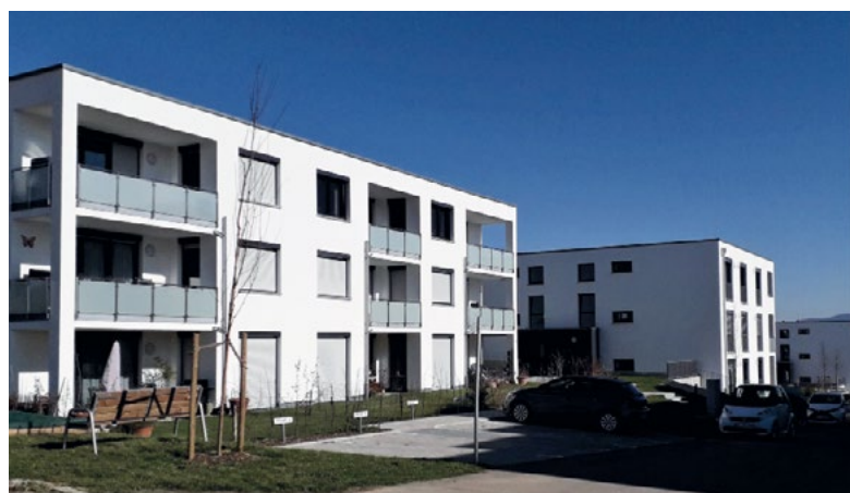
Gebäude Albershausen, Fuchseckstraße 14 - 16
