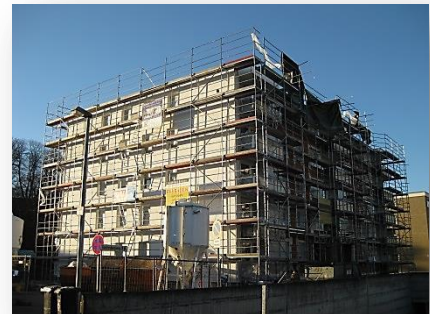
Objekt Göppingen-Holzheim, Reutenbergweg 6 -während Modernisierung-
