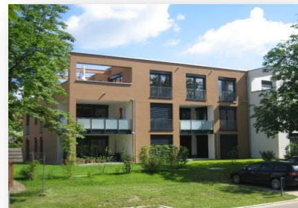
Neubauprojekt Bad Boll, Seilerstraße 6, Haus C
