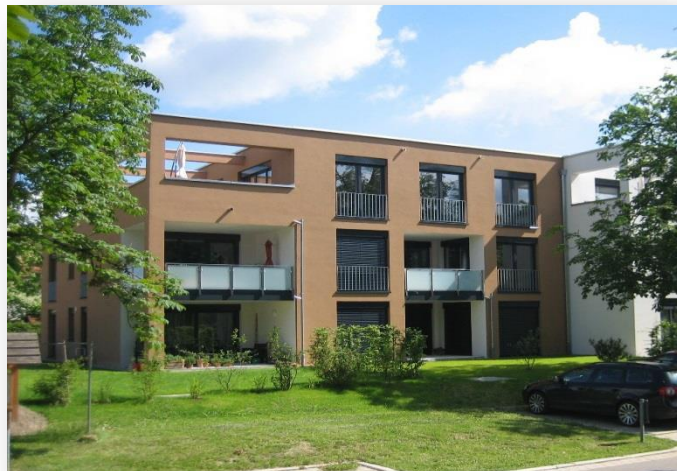
Neubauprojekt Bad Boll, Seilerstraße 6, Haus C
