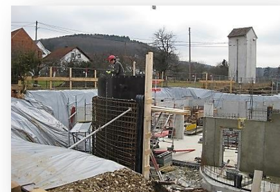
Neubauprojekt Gammelshausen, Schulstraße 3
